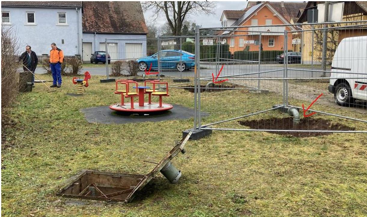
Die Entnahme des Löschwassers soll Zukünftig über einen Ausschnitt im Revisionsdeckel erfolgen, die im Zuge der Maßnahme auch mit getauscht werden sollen. Hierzu wird das Ansaugrohr an der Betonwandung der Revisionsöffnungen befestigt und nach unten in das Wasser geführt. Somit kann die Entnahme des Löschwassers zukünftig über einen geschlossenen Deckel erfolgen und es besteht somit keine Absturzgefahr in den Löschwasserbehälter bei Löscharbeiten
